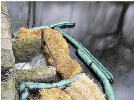
Fotografia nr 6.4. Ograniczanie rozlewiska mazutu na akwencie wodnym (foto J.Gawroński)
